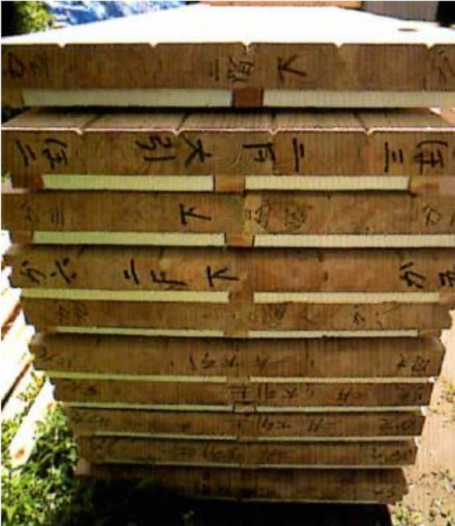
◇ 土台・柱・梁などはもちろん柱と柱の間に組み込む「列柱壁(パネル)」を事前にプレカット工場で作製し、建築現場に持ち込み、在来軸組工法で建築・施工します。
