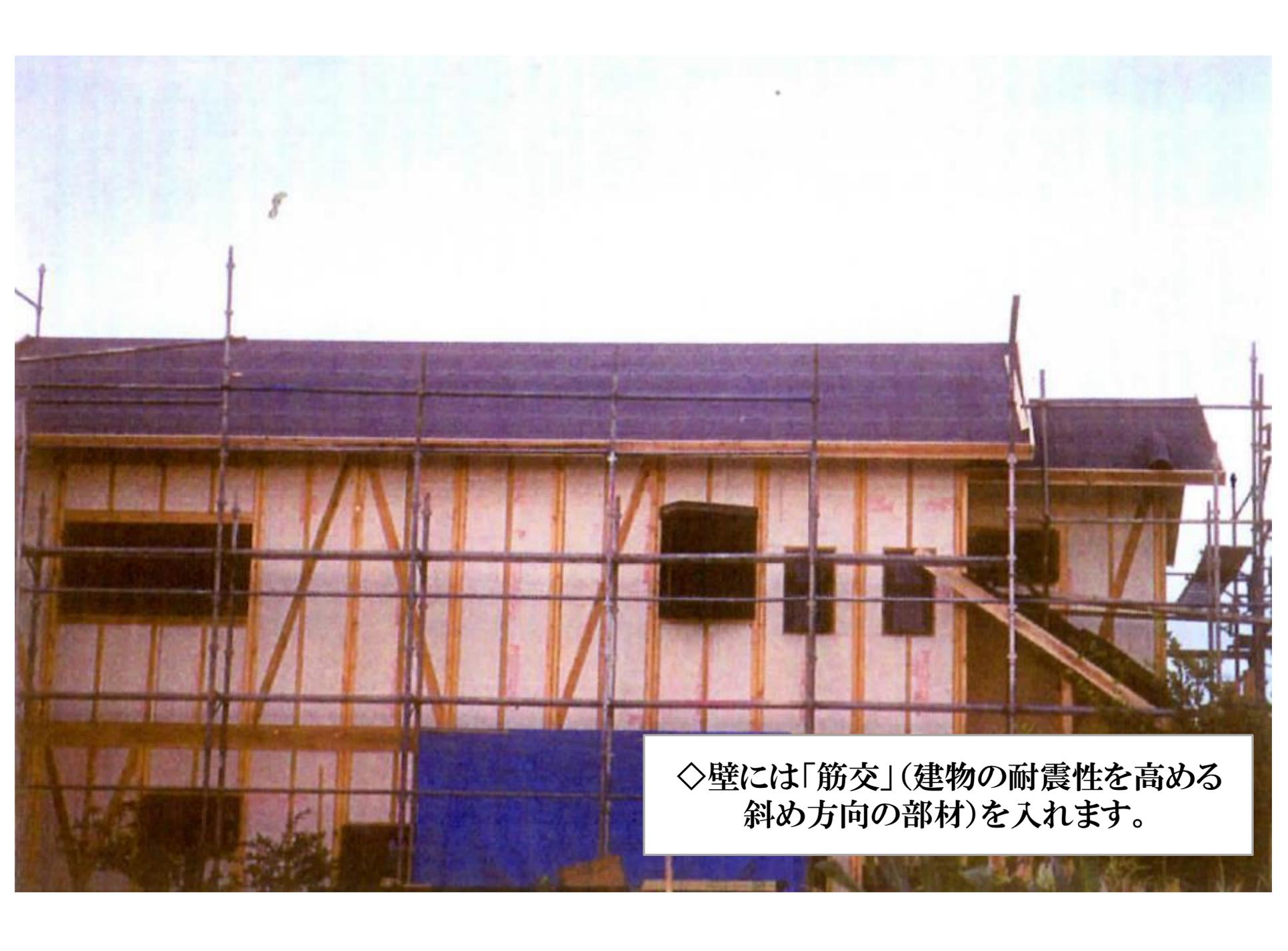
◇壁には「筋交」(建物の耐震性を高める斜め方向の部材)を入れます。
